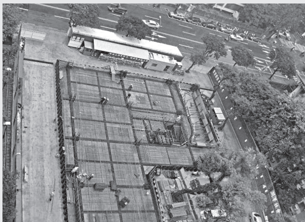
圖一、一樓下層版筋及水電配管施作
